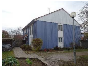
Bild 12: Fl. Nr. 931/6 (Nord-, Ostseite zum BV)
